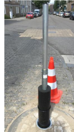
Paal in de fundatiebuis laten zakken 2° Ring sluit de buis af !!!!
