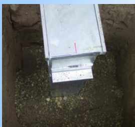
Aanwerken met grind/ zand.
