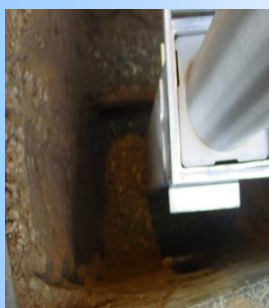
Gat graven 0,50 x 0,50 – 1,0 meter diep !
