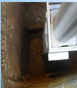
Gat graven 0,50 x 0,50 – 1,0 meter diep !
