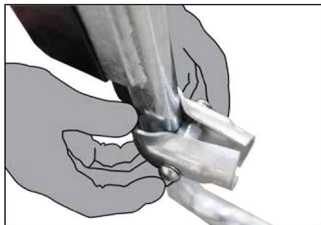
O. Bevestig de meegeleverde klem op het onderste deel van de Kee Gate (net boven het gebogen deel). Bevestig daarna de midden regel. Maak de midden regel vast door de M10 bout vast te draaien op de 6mm inbusbout.
