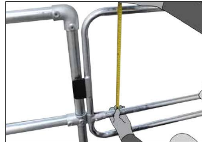
Q. Meet altijd de afstand tussen de midden regel en de boven regel. De afstand tussen beide mag nooit meer zijn dan 470mm.
