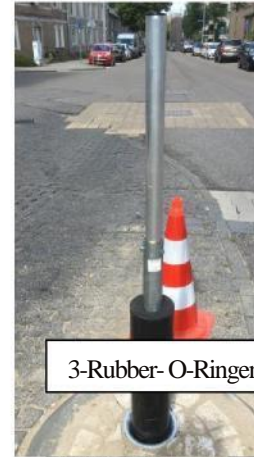
Paal in de fundatiebuis laten zakken 2 e Ring sluit de buis af !!!!
