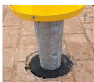
Afwerken met PE afdekdop
