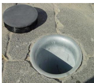
Afwerken met PE afdekdop
