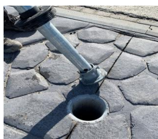
Afwerken met PE afdekdop
