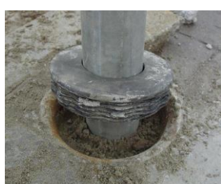
Afwerken met PE afdekdop
