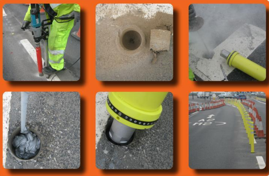
Montage van een NS Pole Cone
