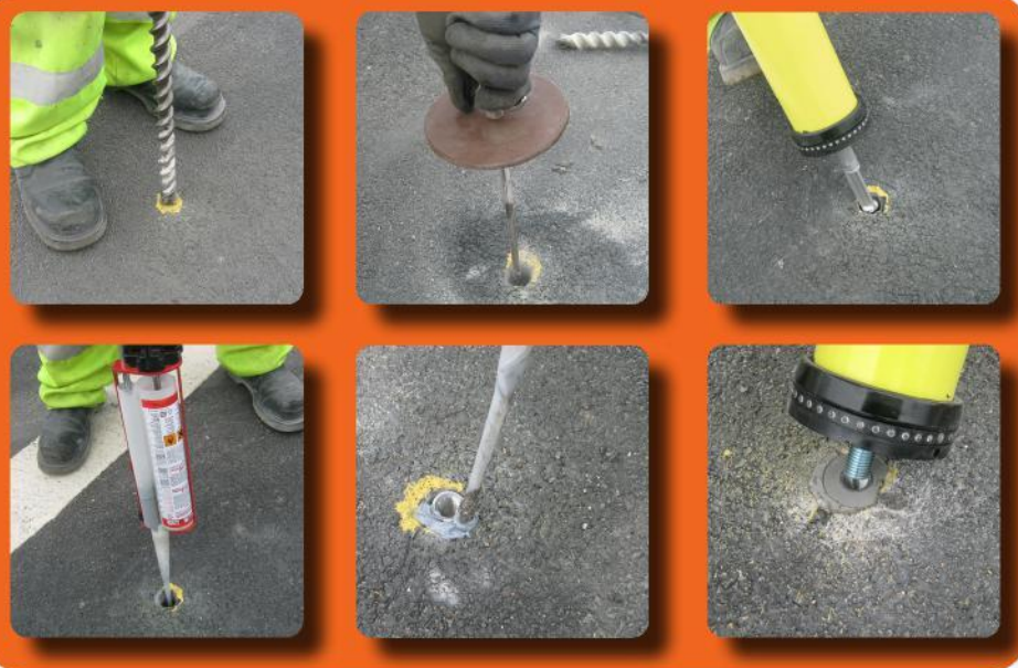
Montage van een NSE Pole Cone
